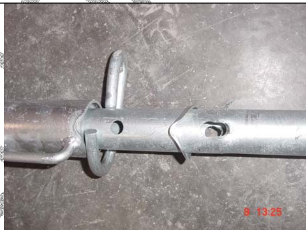
Foto 4: Detalle de ensanchamiento perforación y fractura del pasador
