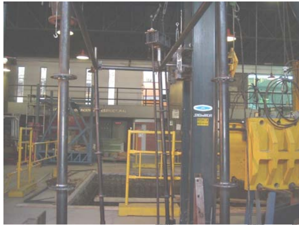
Fotografía 15: Ensayo de carga horizontal dirección transversal. Falla por deformación excesiva.
