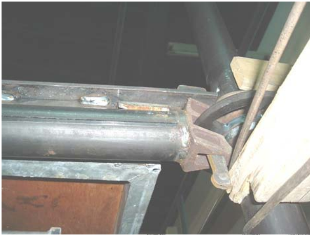
Fotografía 3: Detalle de unión mediante sistema de rodela y cuña.
