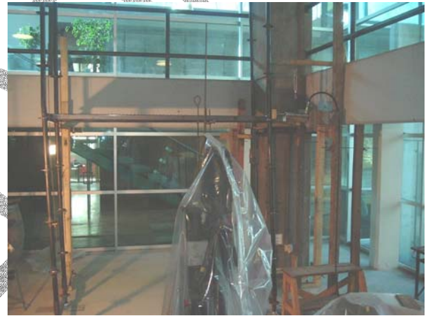
Fotografía 16: Vista general de montaje de ensayo de carga horizontal a dos cuerpos de andamio.
