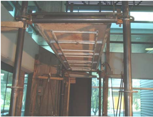
Fotografía 1: Vista de escalera metálica colgante
