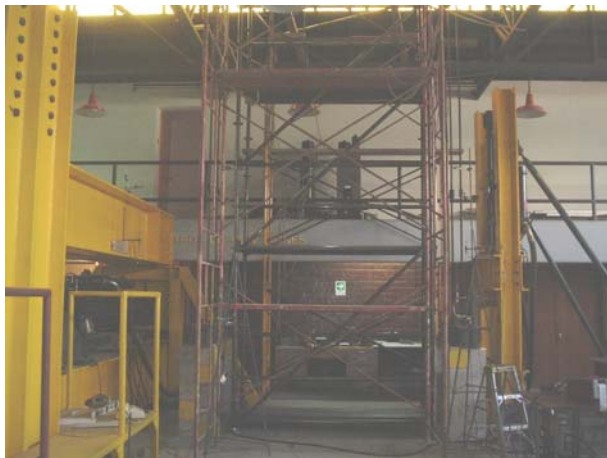
Fotografía 21: Vista general de ensayo de carga vertical a tres cuerpos de andamio.
