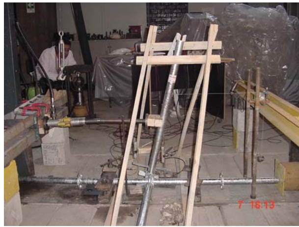
Fotografía 31: Falla por excesivo giro del disco de empotramiento del sistema Pie Derecho - Travesaño.
