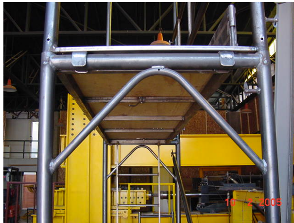
Fotografía 3: Detalle de unión entre cuerpos de andamio.
