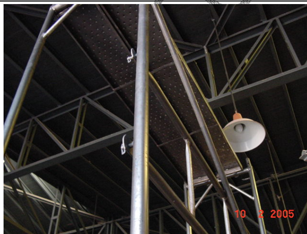
Fotografía 5: Vista inferior de andamio con tabloncillos
