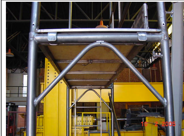
Fotografía 9: Vista de Andamio con Plataforma de Madera
