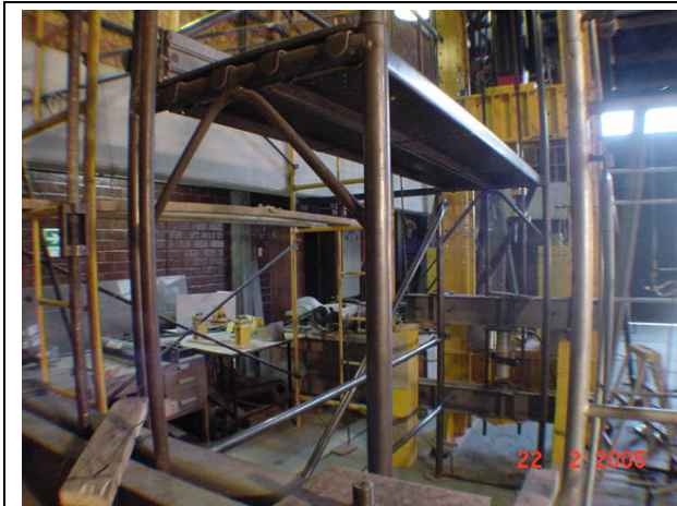
Fotografía 7: Vista general de tabloncillos metálicos en andamio.
