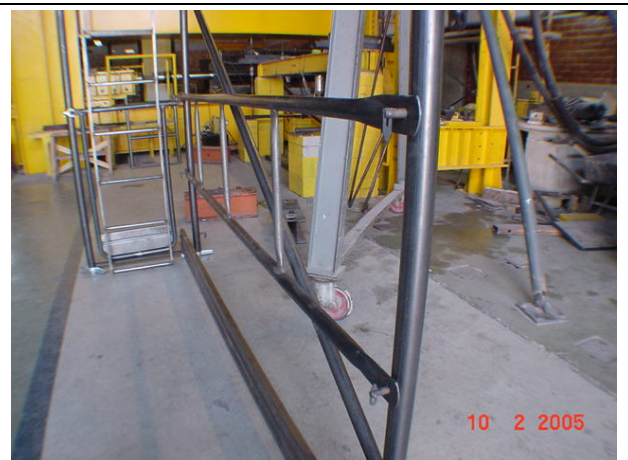
Fotografía 12: Detalle de Baranda Doble
