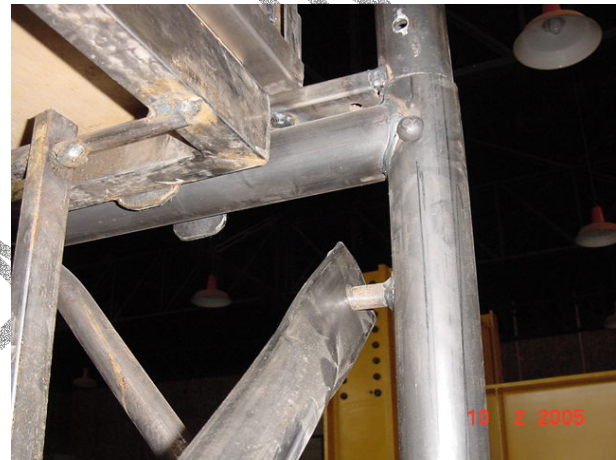
Fotografía 4: Detalle unión pasador-diagonal.
