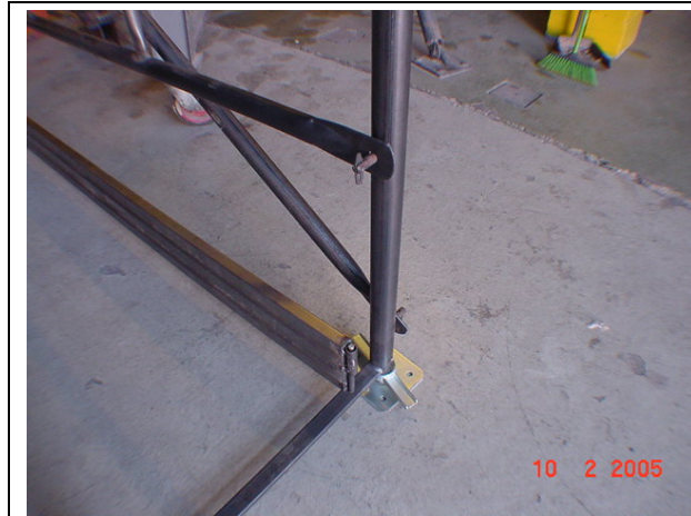
Fotografía 13: Detalle de Baranda Doble
