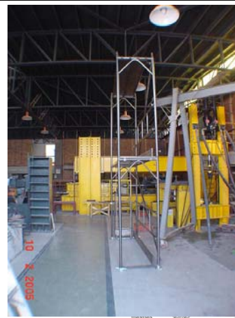
Fotografía 2: Vista Lateral de dos cuerpos de andamios.
